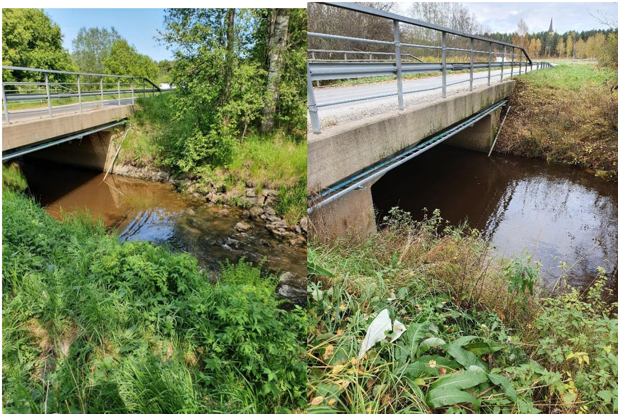
Figur 7 Mät- och provtagningsstation vid bron i Flor. I det galvaniserade röret vid bronns vänstra strand så sitter en nivålogger monterad vid botten. Den vänstra bilden är tagen den 4 juni 2020 och vattenföringen är 130 l/s. Den högra bilden är tagen den 7 oktober 2020 och vattenföringen är 805 l/s.
